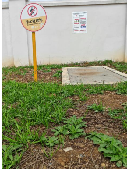
地埋式污水处理设施
